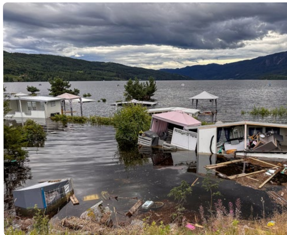
Skader som følge av ekstremværet Hans ved Sperillen. Foto: Åsgeir Størdal
