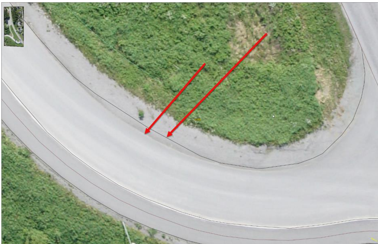
Slurvete konstruksjon i Vegdekkekant oppdaget i Fullstendighetskontrollen.
