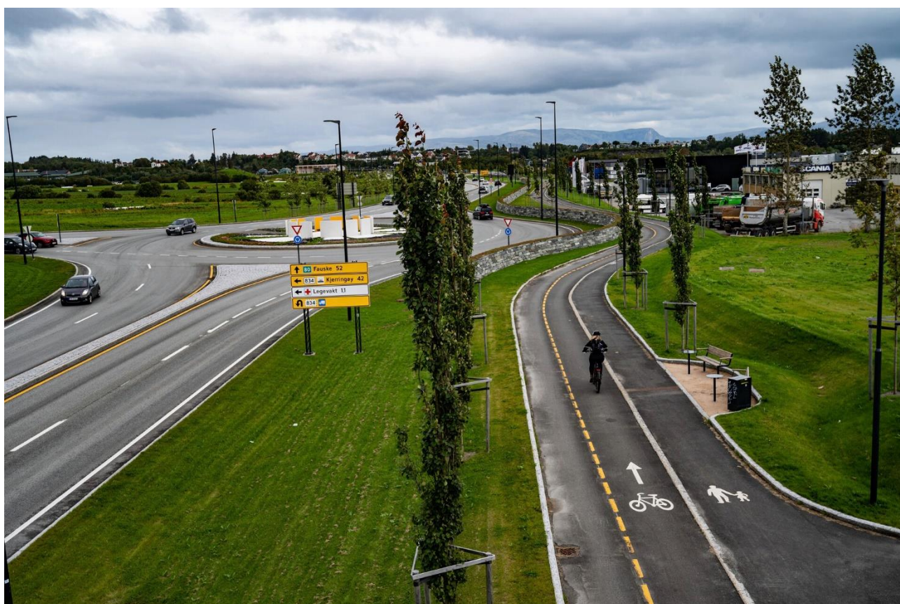
Foto. Bård Asle Nordbø – Statens vegvesen
