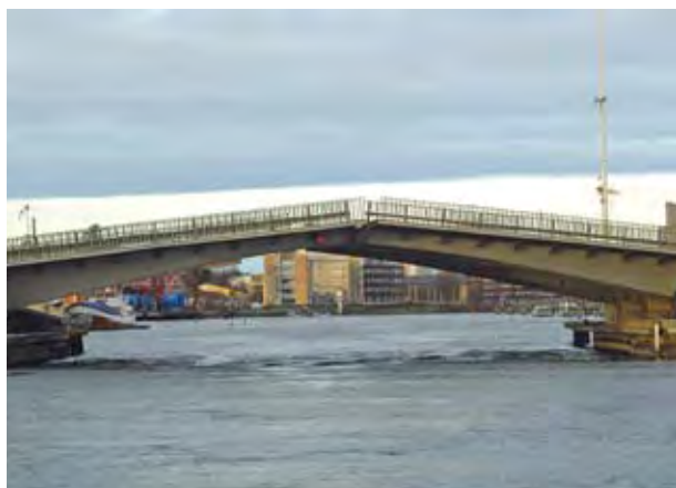
KANALBRUA sett fra SE (2005)
