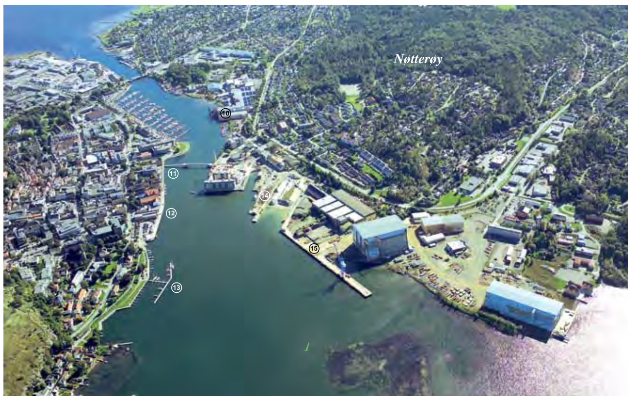
TØNSBERG sett fra NW (2005)
