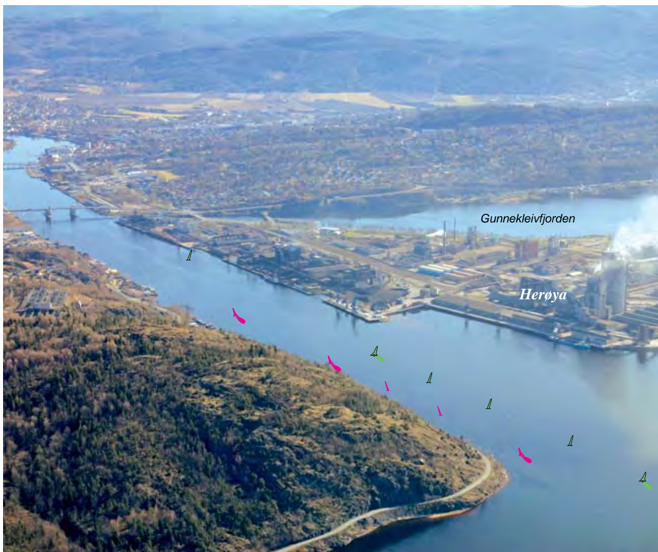
TORSBERGRENNA, Porsgrunn, sett fra SW (2005)
