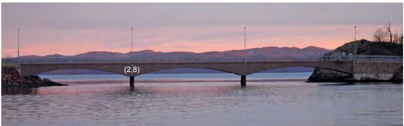
Brua over Løvøysundet sett fra S (2005)
