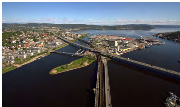
HOLMEN, Drammen, sett fra W (2016)
