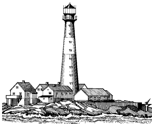
Torbjørniskjær (58°59,8'N 10°46,9'E), 18 m høyt, granitthus med lavt tårn. Lysets høyde 25,5 moh. Sett fra N.
