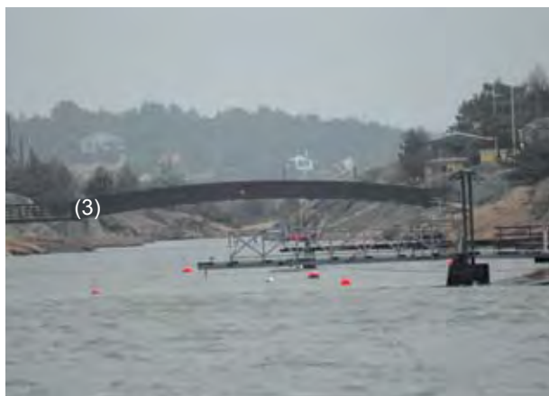
Brua ved Stokken sett fra S (2005)
