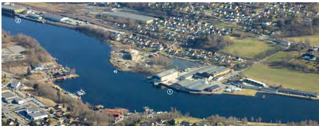
BORGESTAD, Skienelva, sett fra SW (2005)
