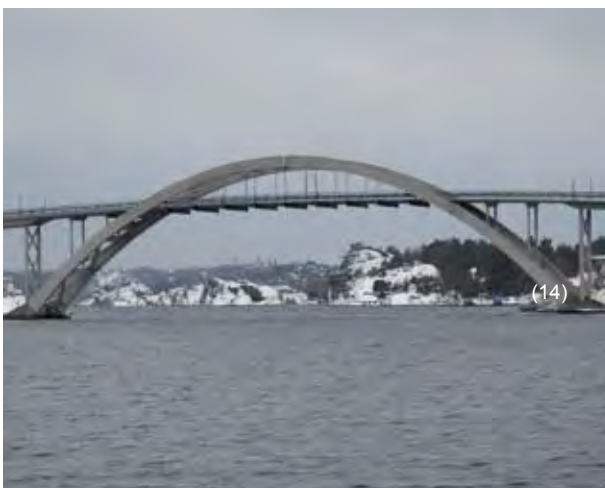
RØSSUND BRU sett fra N (2005)
