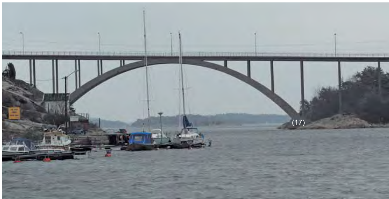
Skjelsbusund bru sett fra S (2005)
