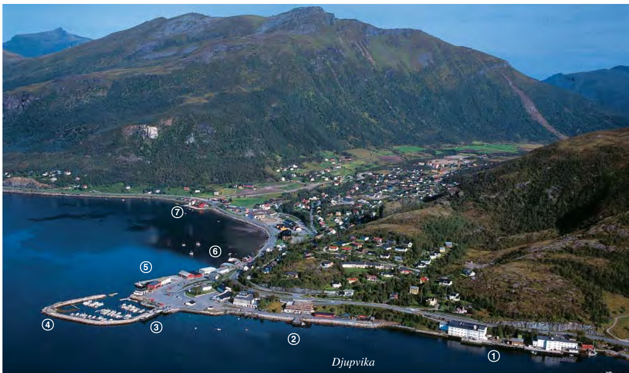
ØRNES sett fra SE (1997)
