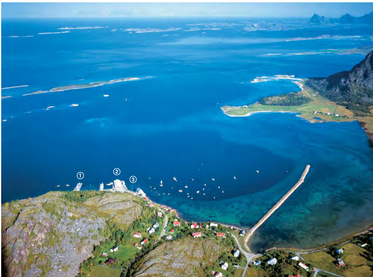
NORDSKOT sett fra S (1997)
