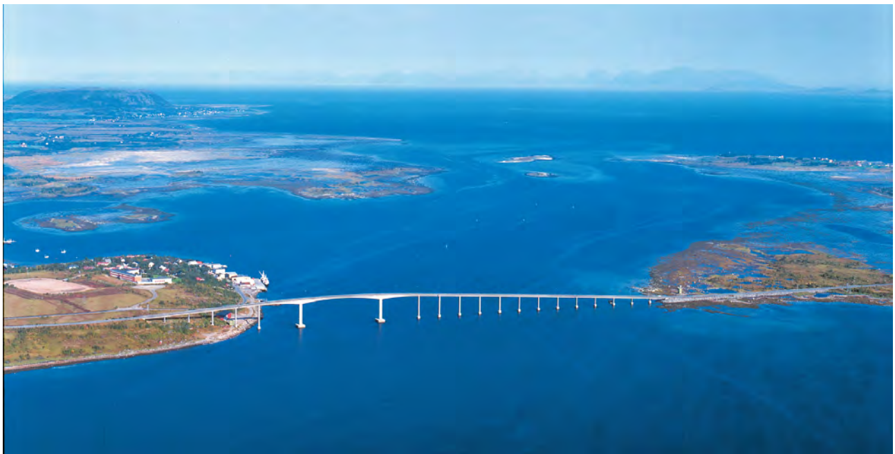
RISØYRENNÅ sett fra SW (1998)
