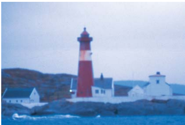
TRANØY FYR sett fra NNW (1995)
