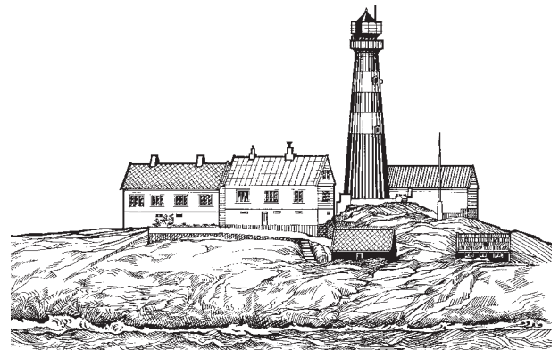
Landegode (67°26,8'N 14°22,9'E), 29 m høyt, rødt jerntårn med 2 hvite belter. Lysets høyde 40,8 moh.
