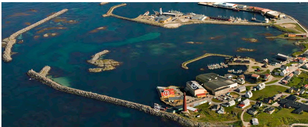
ANDENES sett fra SW (2007)
