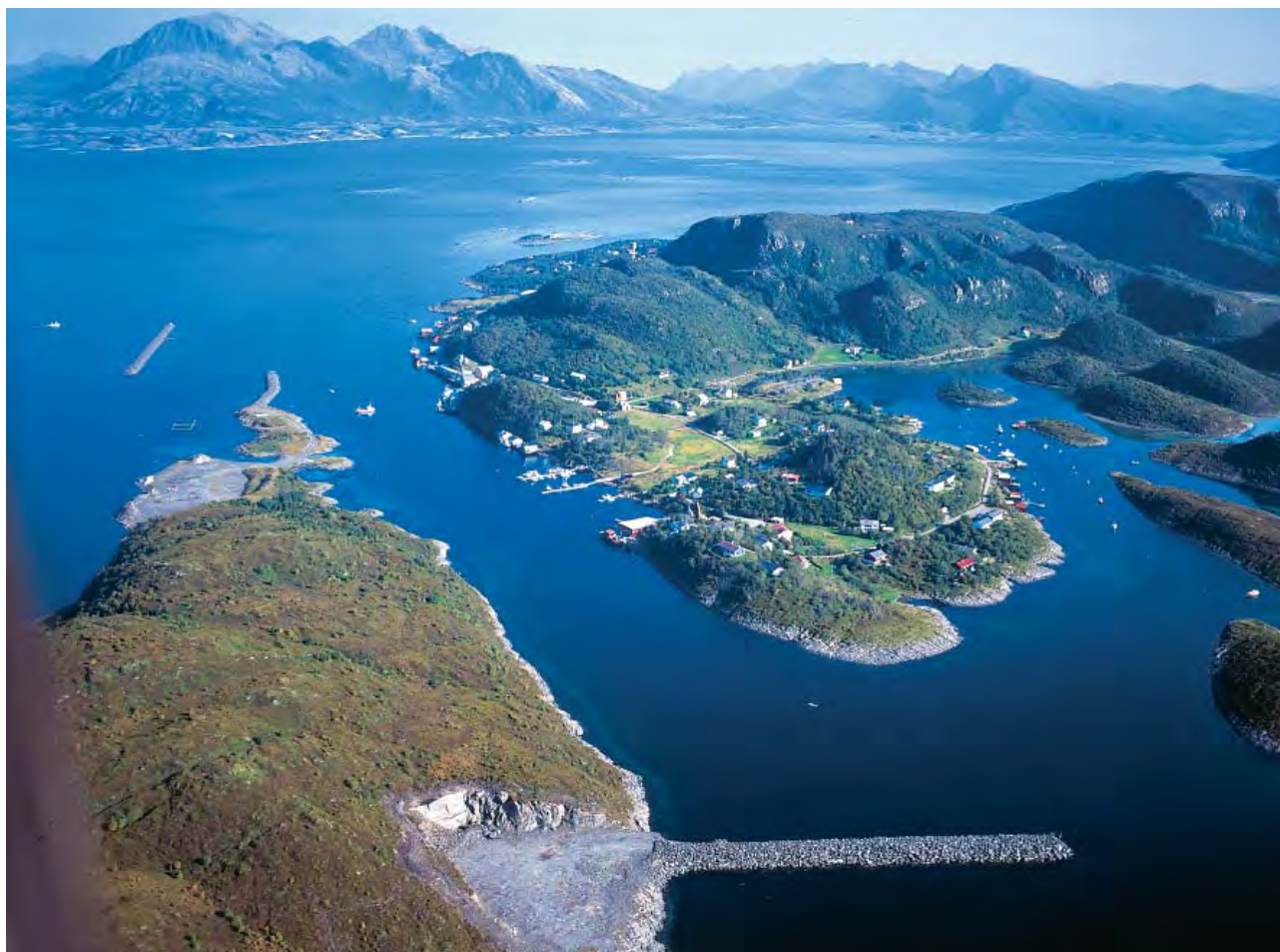
HELNESSUND sett fra SW (1997)
