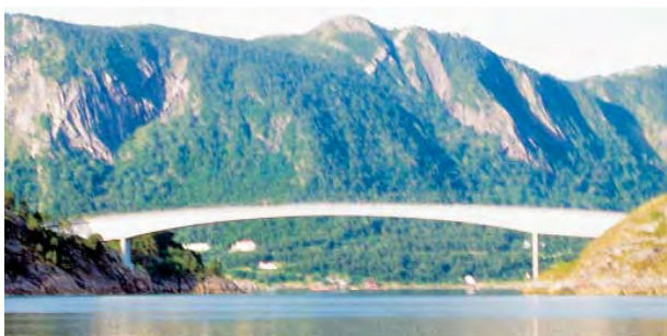
Brua mellom Storøya og Brattholmen sett fra S FOTO: Kartverket (1995)
