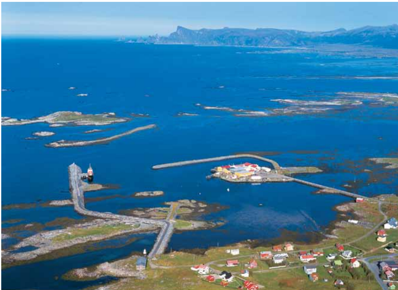
NORDMELA sett fra SW (1997)
