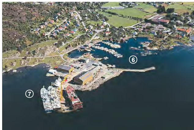
Fitjar Mekaniske Verksted sett fra NW (2000) FOTO: Eiliv Leren
