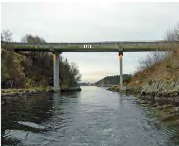
RØYKSUND BRU sett fra NE (2000)
