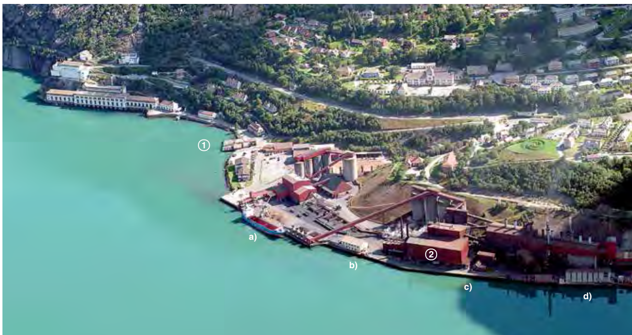
TYSSEDAL sett fra SW (2010)
