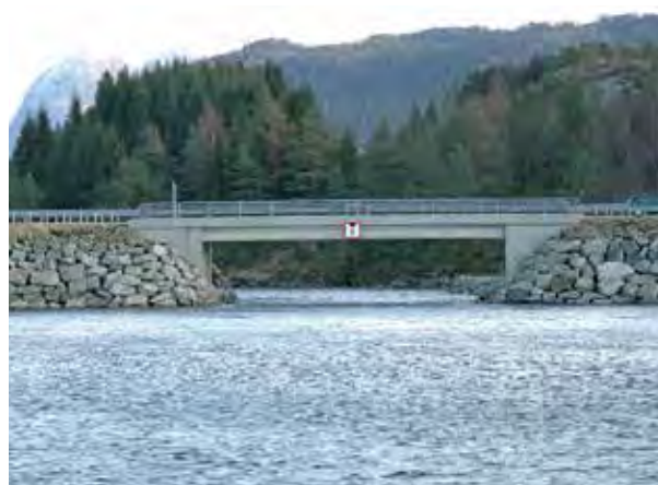
DUESUNDET BRU sett fra SW (4) (2010)
