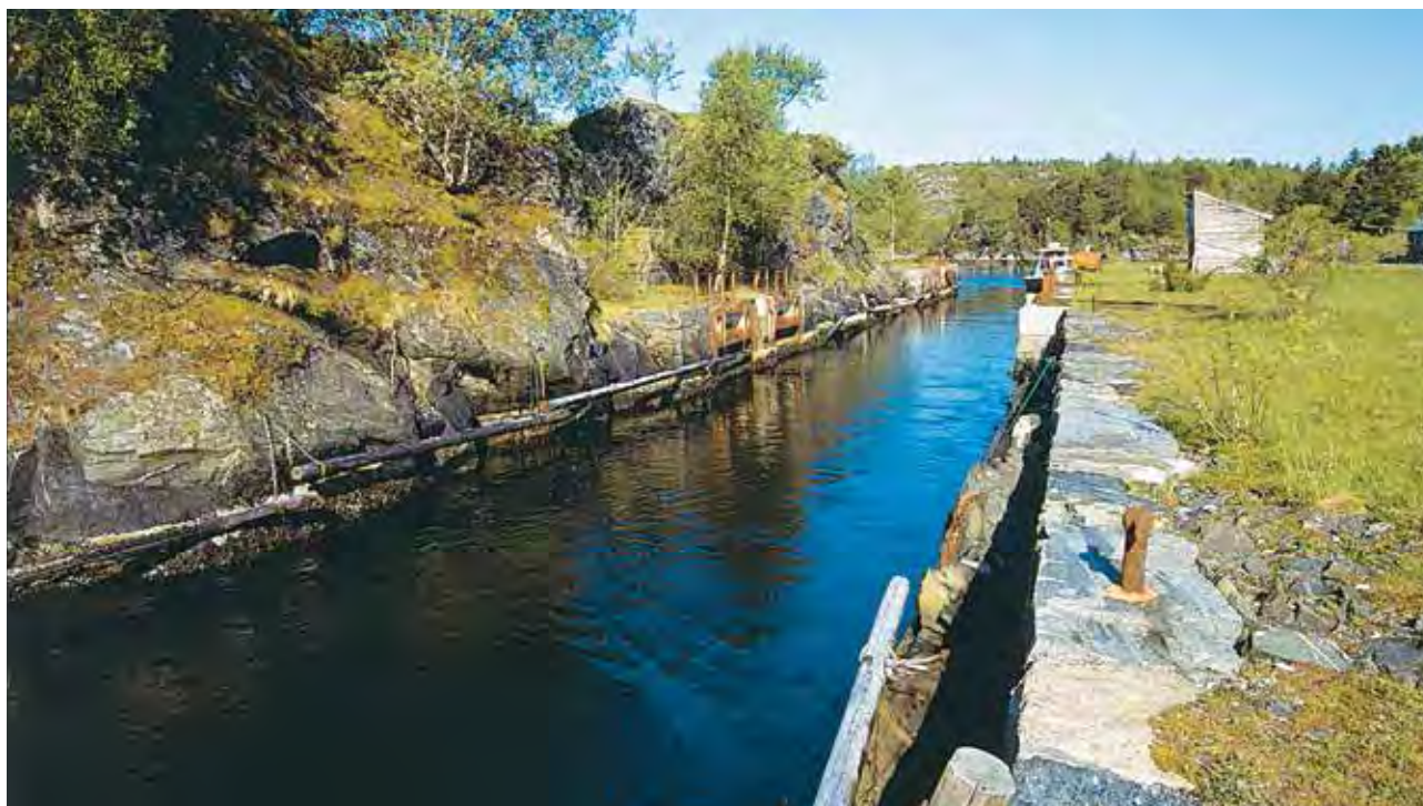
Tidligere slusen i LINDÅSSTRAUMEN sett fra SE (2000)
