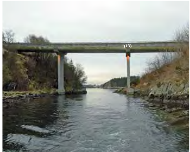
RØYKSUND BRU sett fra NE (13) (2000)
