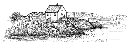
Vikeholmen (59°07,9'N 5°14,6'E), 8,5 m høyt, hvitt steinhus. Erstattet av lykt, 7,5 moh, sett fra SE.
