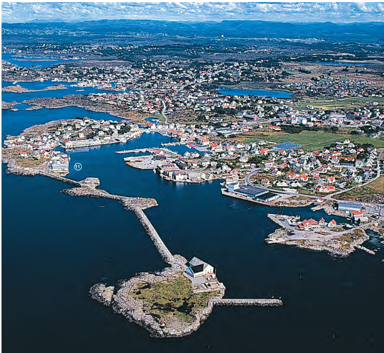
ÅKREHAMN sett fra SW (2000)
