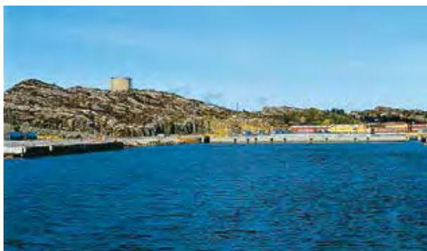
Dypvannskaien ved Hanøytangen (2000)
