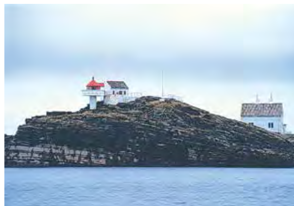
FJØLØY LYKT og fyrbygning sett fra S (2000) FOTO: Kartverket
