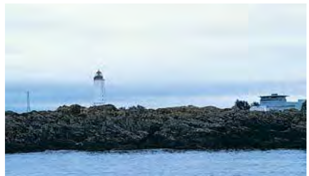
KVITSØY FYR og trafikksentralen sett fra W FOTO: Kartverket (2000)
