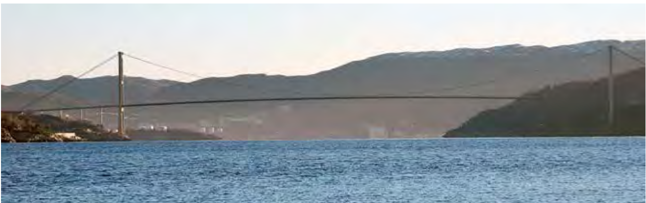
ASKØYBRUA sett fra SW (63) (2010)
