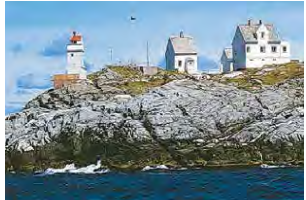
RYVARDEN FYR sett fra SW (2000)
