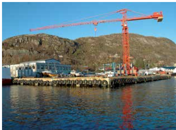
MÅLØY VERFT, Skavøypollen (2010)
