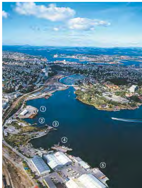
HILLEVÅG sett fra SSE (2000)
